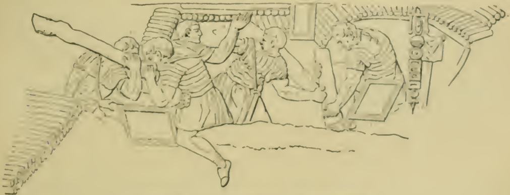
(Construction d'un retranchement. (Bas-relief romain))
